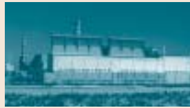
Kernkraftwerk Paks, Ungarn.
