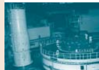
Reaktorbehälter im Kernkraftwerk Paks, Ungarn.
