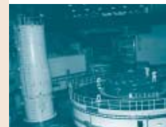
Cuve du réacteur de la centrale nucléaire de Paks, Hongrie.
